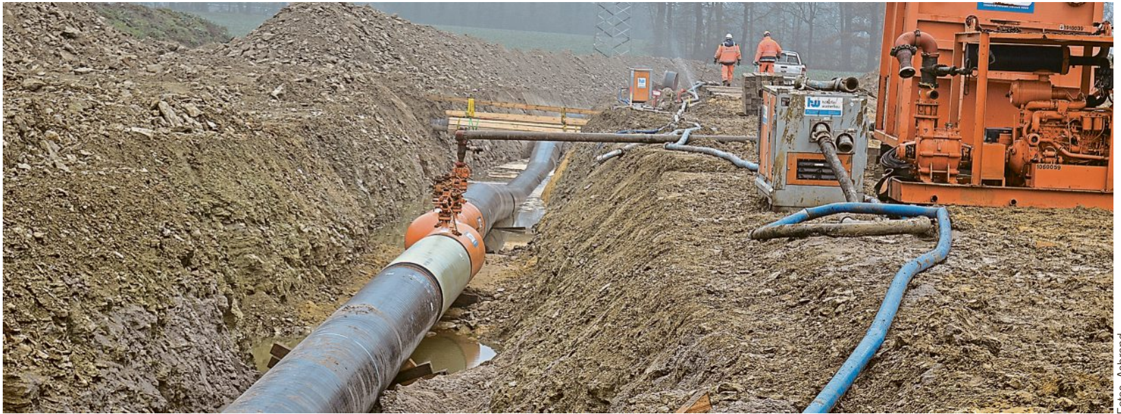
Am 9. Dezember 2020 auf der Baustelle bei Legden, Kreis Borken. Im Rohrleitungsgraben steht Wasser, was eigentlich nicht sein sollte.
